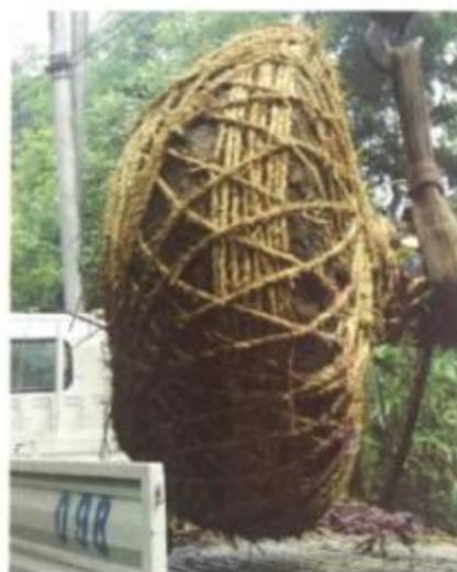
2、小心起吊装车，在土球下方垫软物
