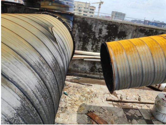
图 3 切割主管道与旧管道
