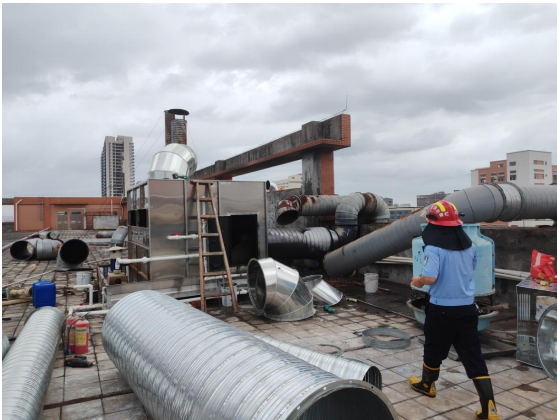
图 2 事故发生后现场
