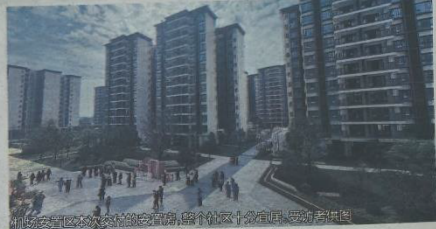
白云机场三期安置区交付现场,每个小区10幢楼,交付约4000套安置房...
