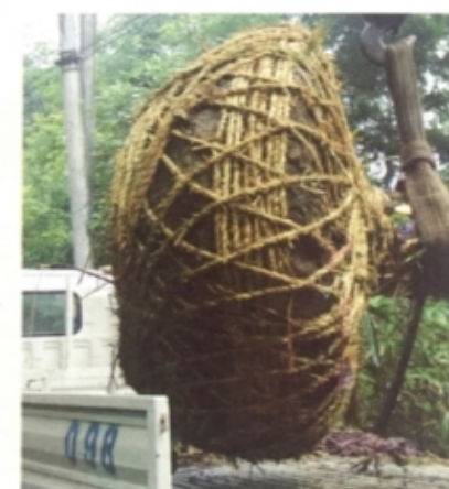
2、小心起吊装车，在土球下方垫软物
