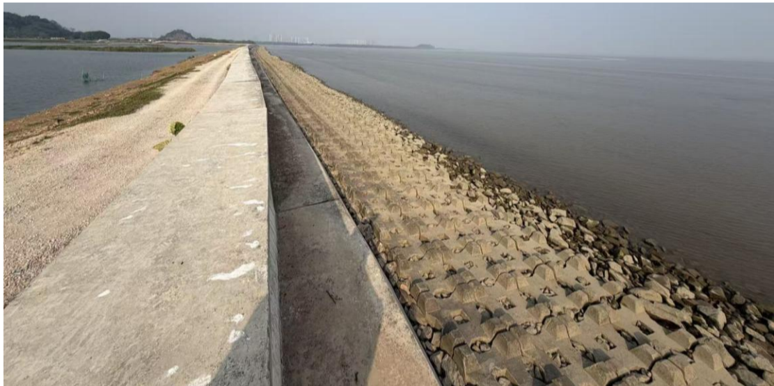
图 2.4.2-14 三茅头堤围东堤现状图
