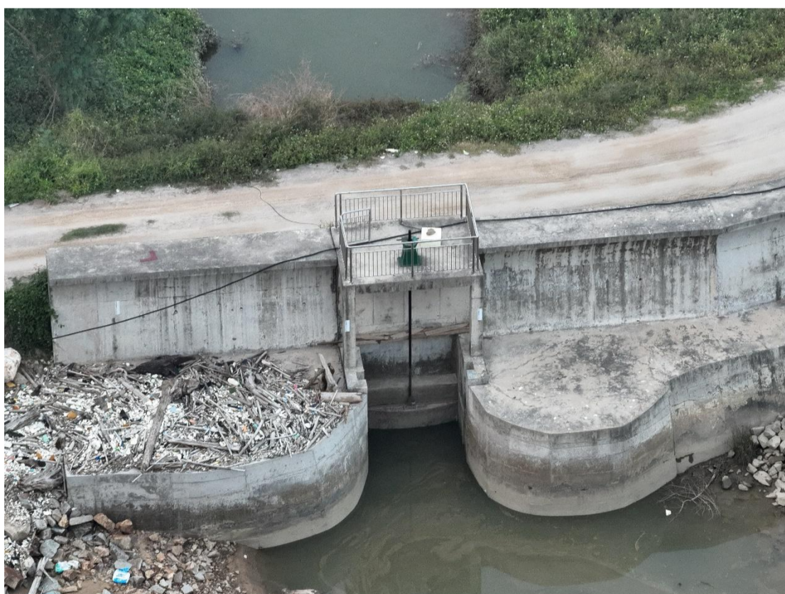
图 2.3.2-5 建设完成后 1#涵闸实勘图
