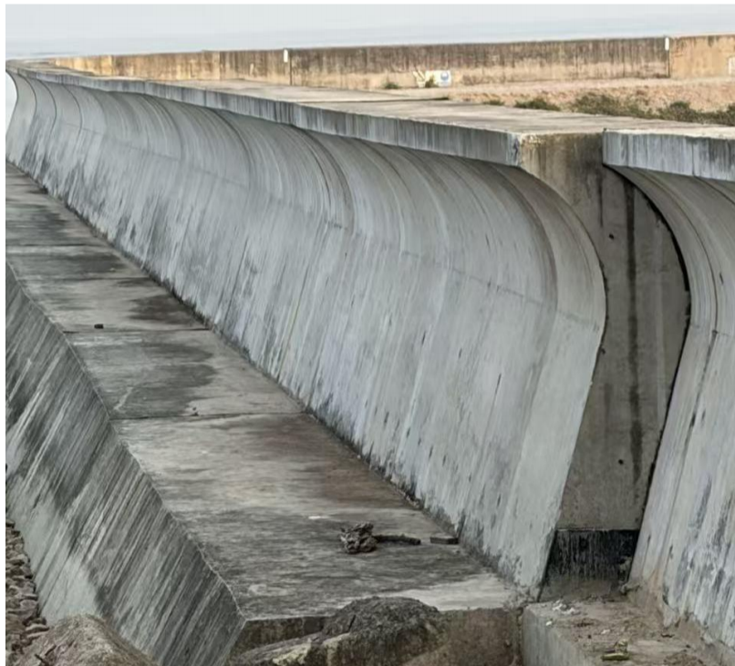
图 2.4.2-5 干砌石+砼幕墙挡墙断面图
