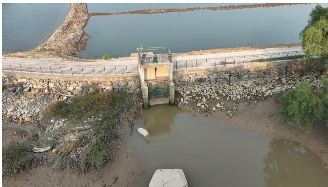
图 2.3.2-9 建设完成后 2#涵闸实勘图
