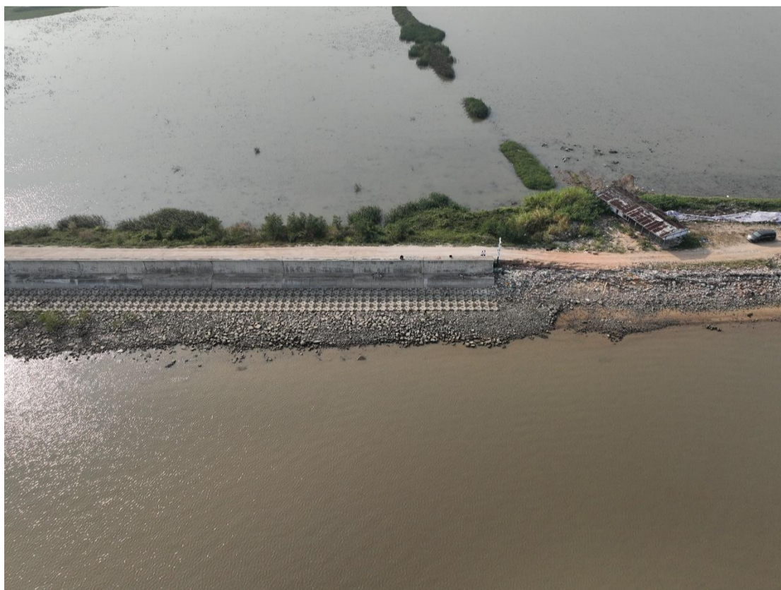
图 2.3.2-3 建设完成后大茅头终点段实勘图 (D0+300~D0+450)
