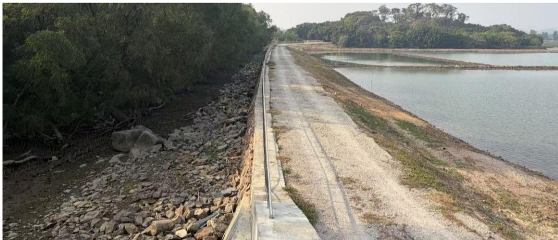
图 2.4.2-16 三茅头堤围南堤现状图
