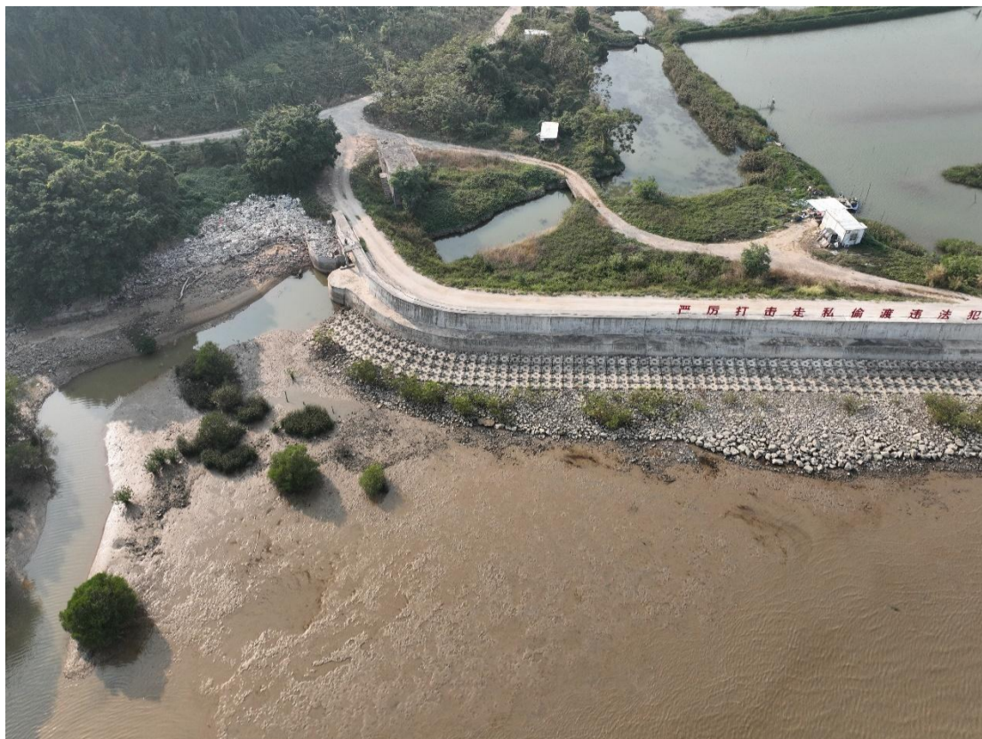
图 2.3.2-4 建设完成后大茅头起点段实勘图 (D0+000~D0+100)
