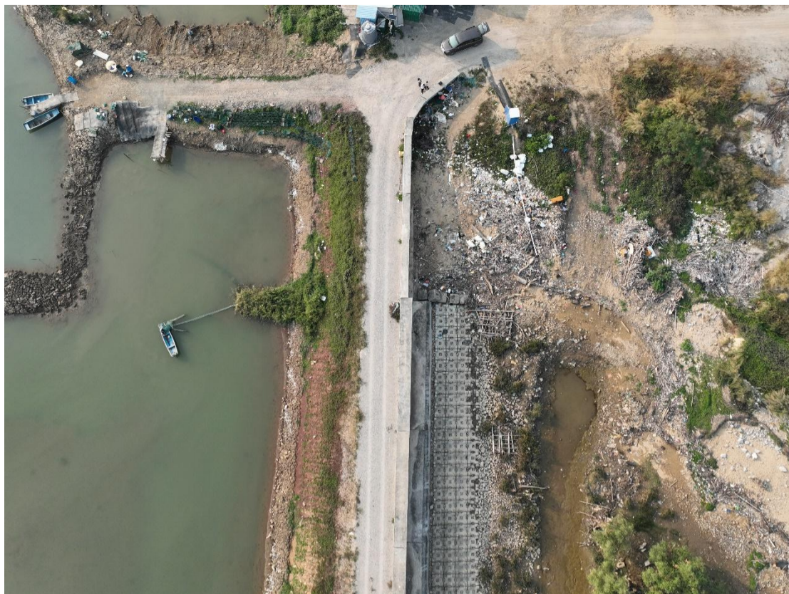
图 2.3.2-6 建设完成后三茅起点段实勘图 (S0+000~S0+050)
