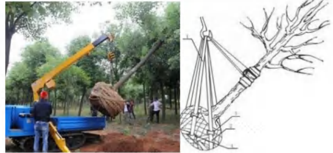
图 6-4 树体起吊、运输示意图
