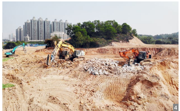
图1 奠基仪式 图2 操场效果图 图3 效果图 图4 施工现场
