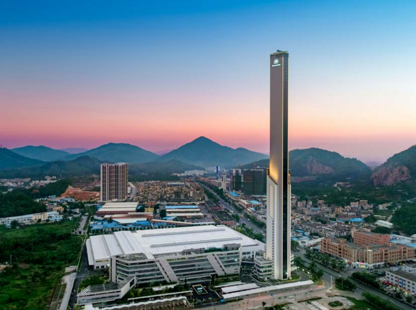
蒂升电梯试验塔
