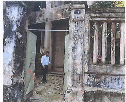
临路铁门及庭院
