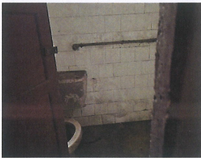
室内实景（卫生间）
