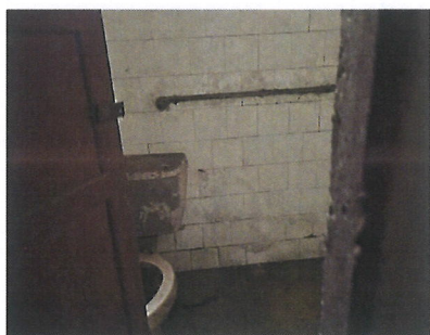
室内实景（卫生间）
