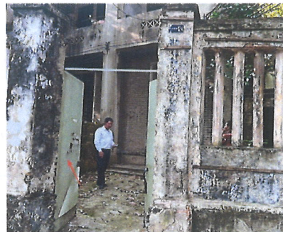
临路铁门及庭院
