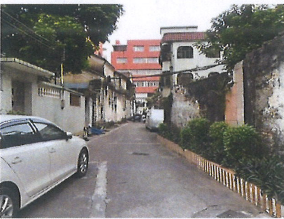
周边环境（一中施工前）
