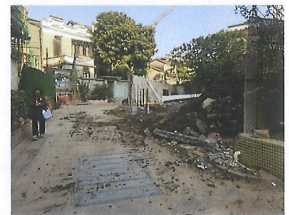
周边环境（一中施工中）
