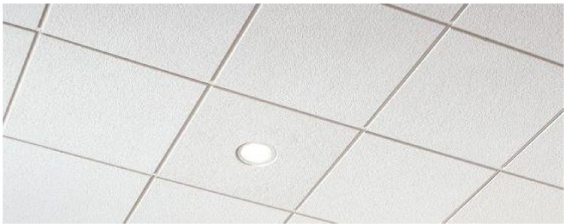
当有卫生间时，卫生间吊顶为300mm*300mm 白色铝扣板集成吊顶
