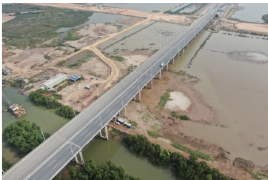
图 4.1.2-6 中山东部快线东部特大桥项目
