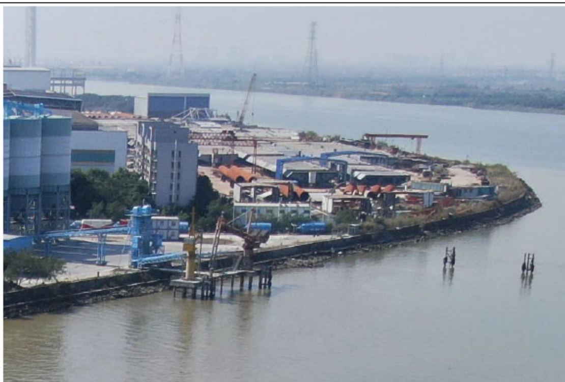
图 4.1.2-4 炬达混凝土公司码头
