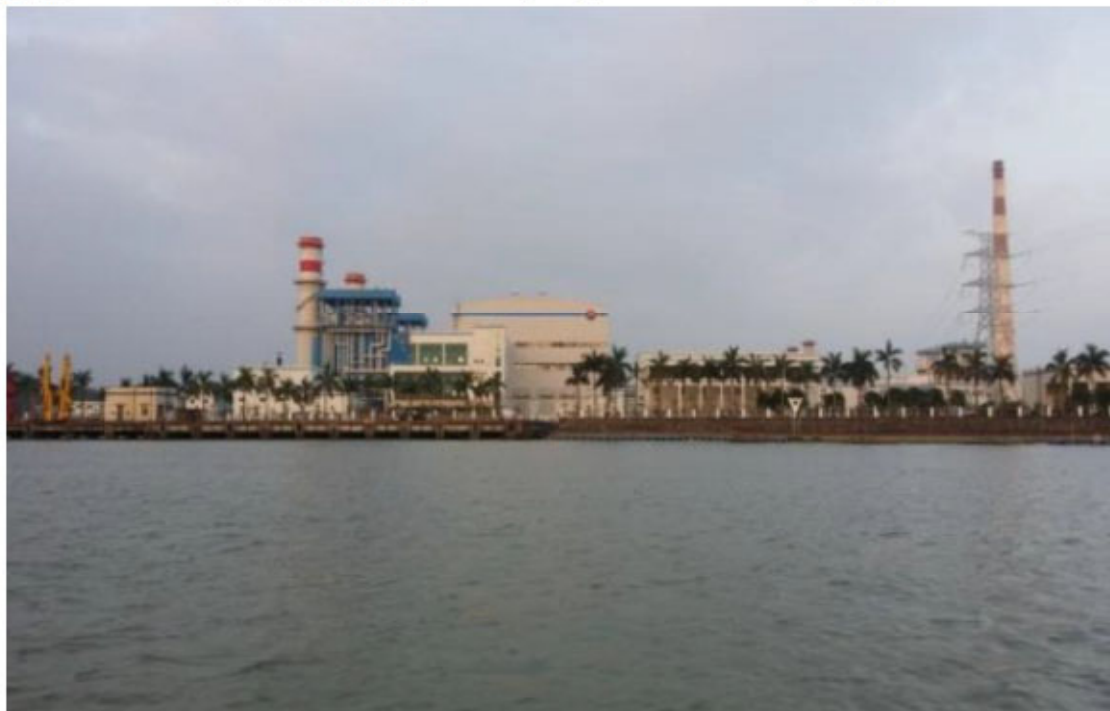
图 4.1.2-2 横门发电厂自用燃料码头
