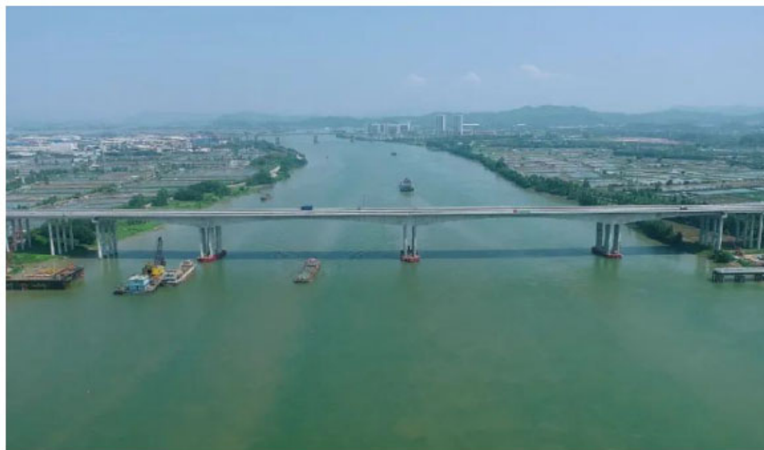
图 4.1.2-5 中山至开平高速公路（含小榄支线）横门西水道大桥工程
