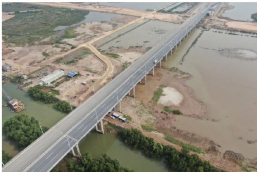
图 4.1.2-6 中山东部快线东部特大桥项目
