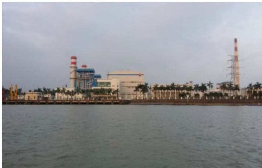
图 4.1.2-2 横门发电厂自用燃料码头
