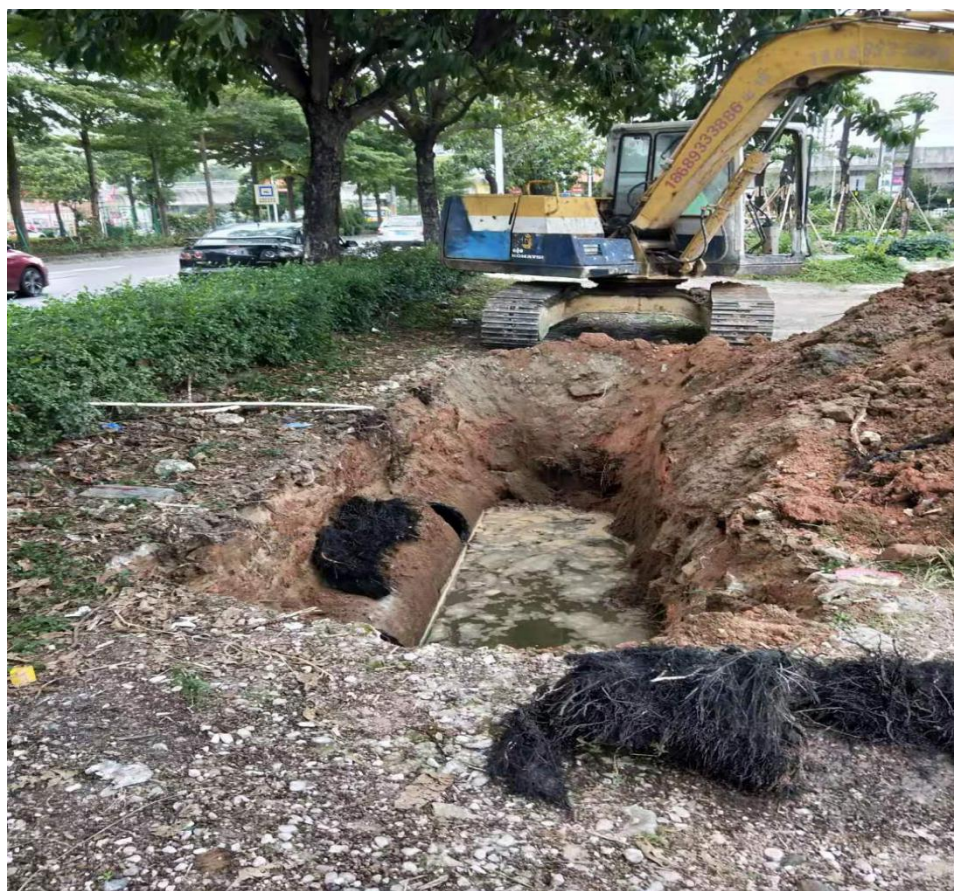
水翁根系堵塞道路排水井口示意图
