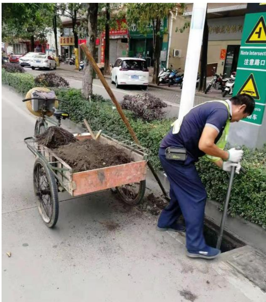
水翁根系堵塞道路排水井口示意图
