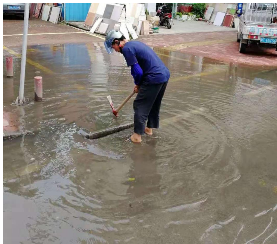
水翁根系堵塞道路排水口导致道路积水示意图
