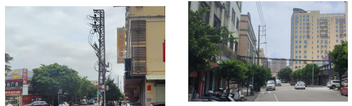
曹一工业大道现状高压线塔相片
