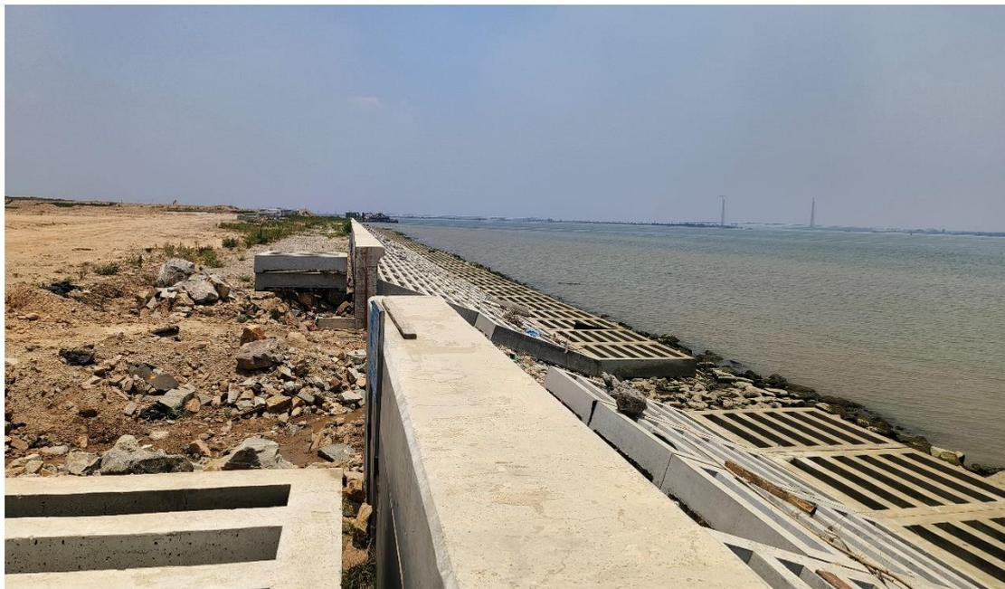
图 2.1.2-4 东北侧海堤加固工程实施现状
