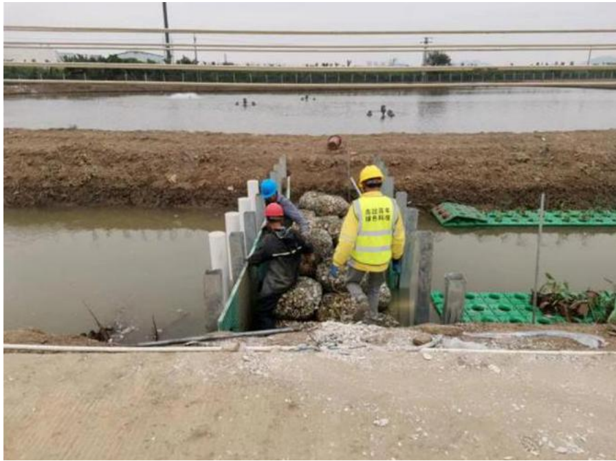
▲尾水工程施工现场
