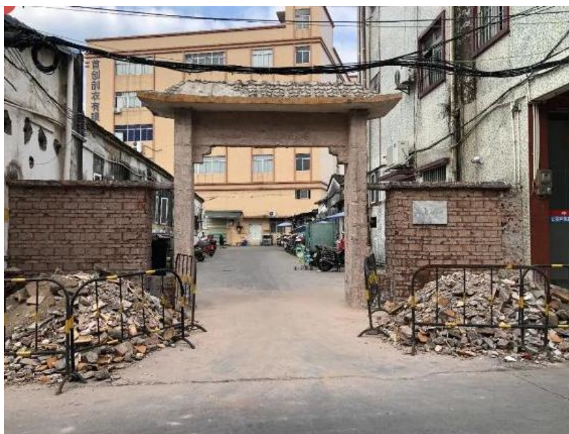
图 | 大涌南文学校旧址修缮前
