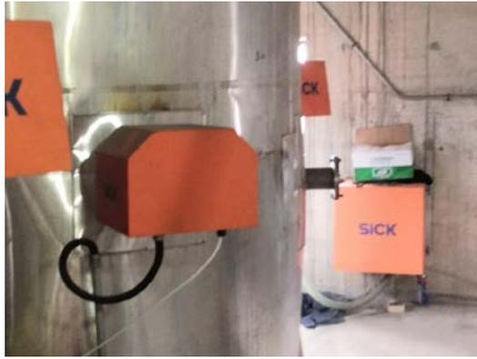
图 10.6-1 废气监测平台与监测孔
