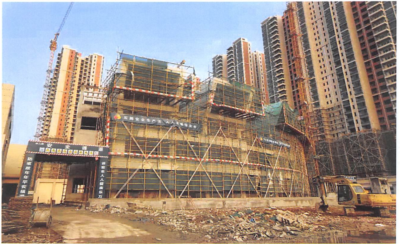
1#商业楼、2#商业楼基本施工完成；幼儿园：天面防水基本完成，外墙涂料施工完成约35%，内墙刮腻子完成约20%，地面找平约50%，铝合金门窗完成约80%。
