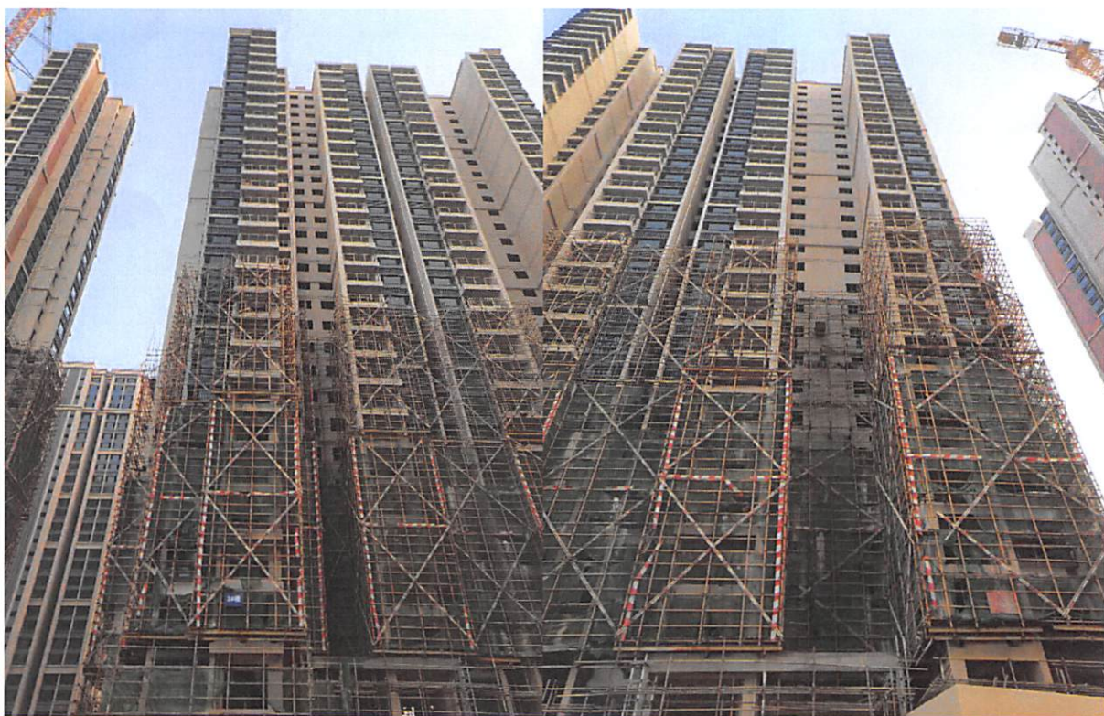
3 栋(外架拆除完成 17 层，地面找平完成 15 层)
