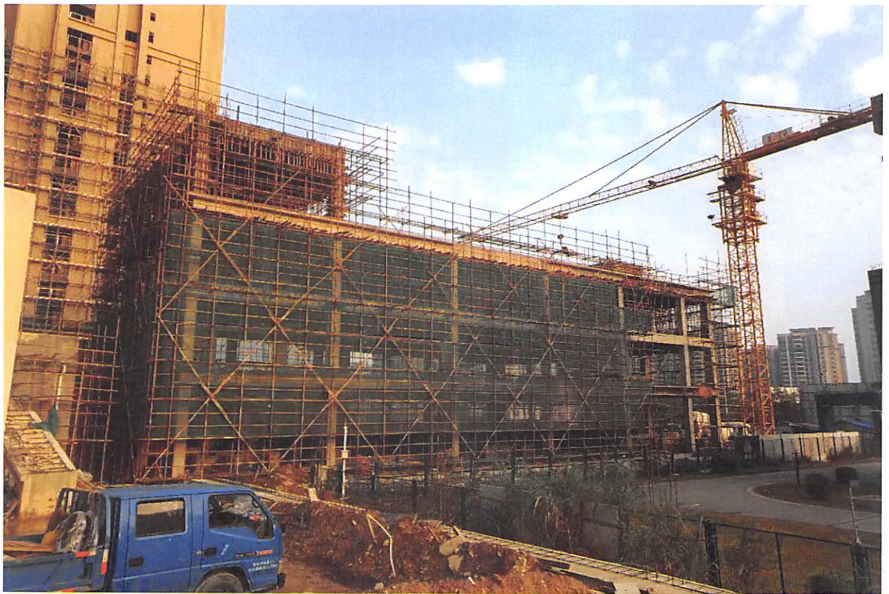
综合楼：结构砼浇筑基本完成，墙体砌筑开始。
