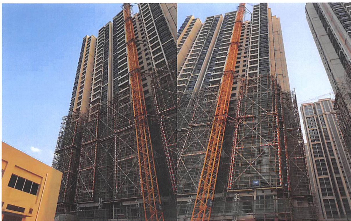
1 栋(外架拆除完成 17 层，地面找平完成 8 层)
