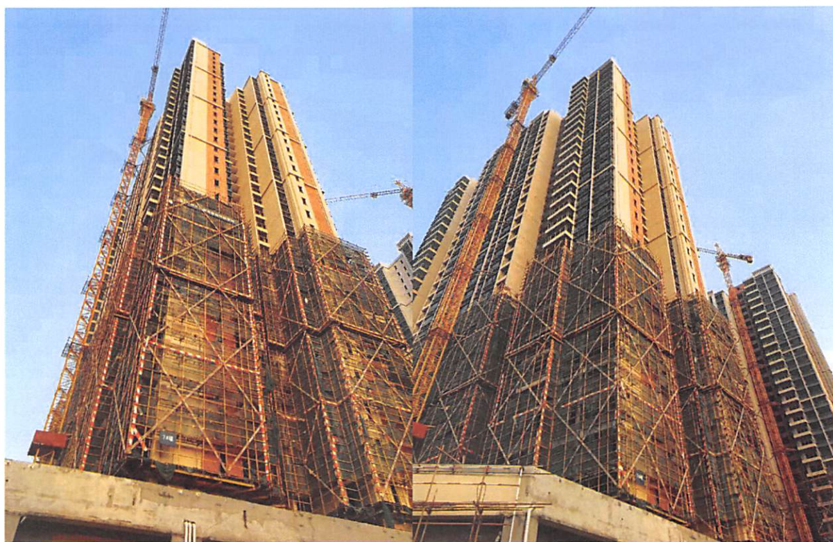
7 栋（外架拆除完成 19 层，地面找平完成 7 层） 8 栋（外架拆除完成 19 层，地面找平完成 13 层）
