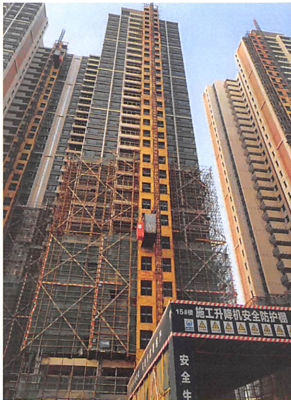
15 栋（外架拆除完成 19 层，地面找平完成 8 层）16 栋（外架拆除完成 24 层，地面找平完成 12 层）
