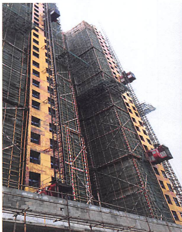
1 栋(外墙防水 95%，外墙砖粘贴 25 层)
