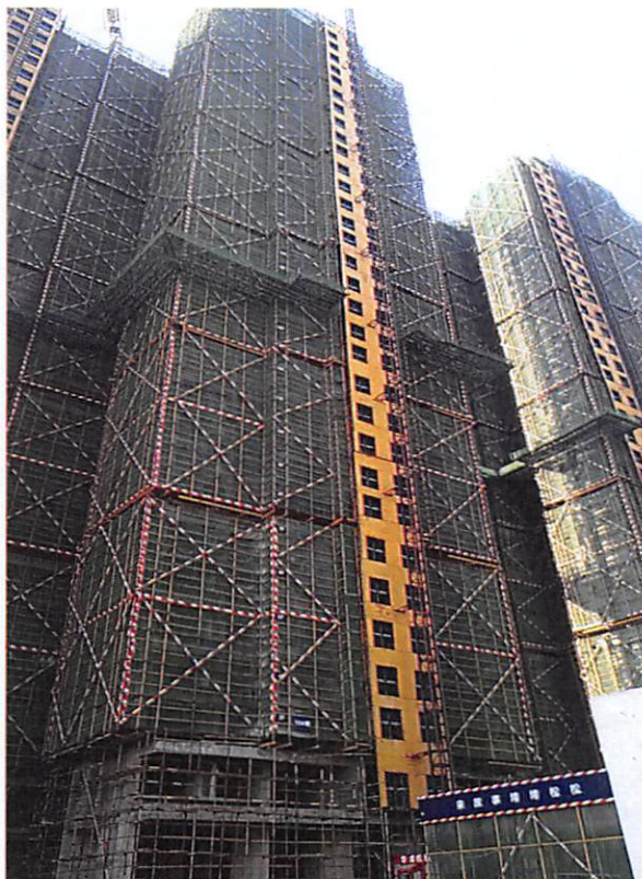
15栋 (外墙防水 90%, 外墙砖粘贴 15 层)
