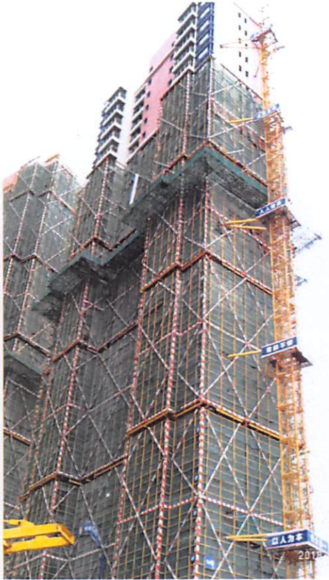
9 栋 (外墙防水 95%, 外墙砖粘贴 15 层)
