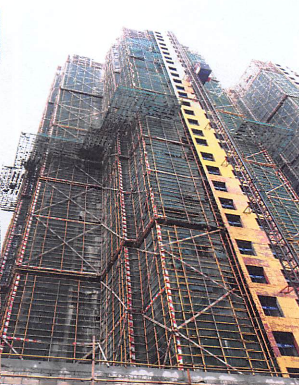
4 栋(外墙防水 90%，外墙砖粘贴 20 层)
