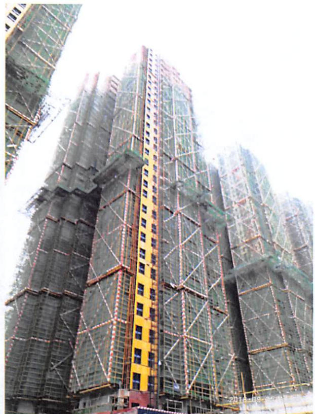
16栋 (外墙防水 60%, 外墙砖粘贴 17 层)
