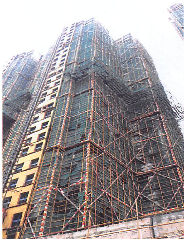
3 栋(外墙防水 95%，外墙砖粘贴 22 层)
