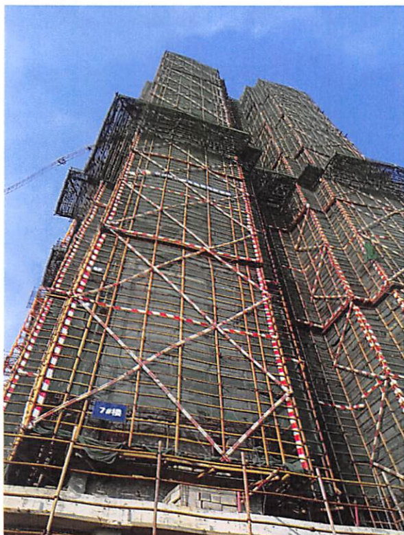
7栋 (外墙防水 90%, 外墙砖粘贴 12 层)
