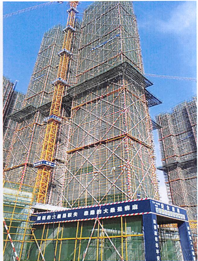
12 栋 (外墙防水 95%, 外墙砖粘贴 17 层)
