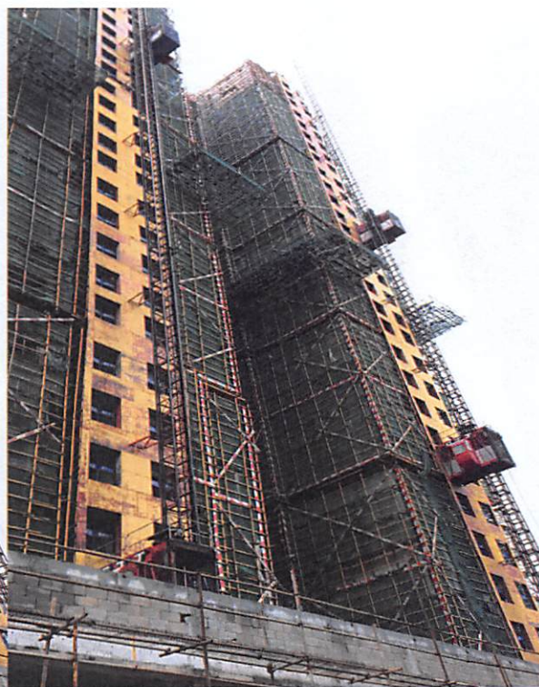
2 栋(外墙防水 95%，外墙砖粘贴 26 层)
