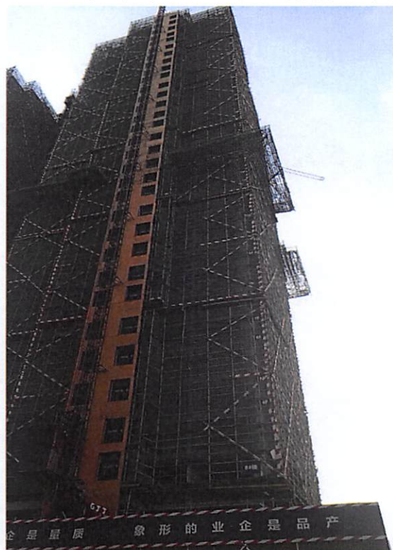
8栋 (外墙防水 70%, 外墙砖粘贴 12 层)
