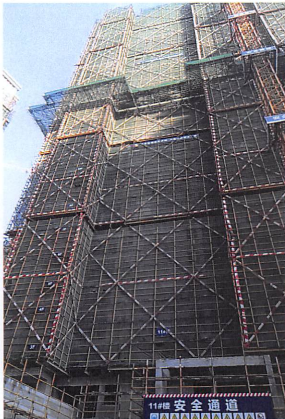
11 栋 (外墙防水 80%, 外墙砖粘贴 16 层)
