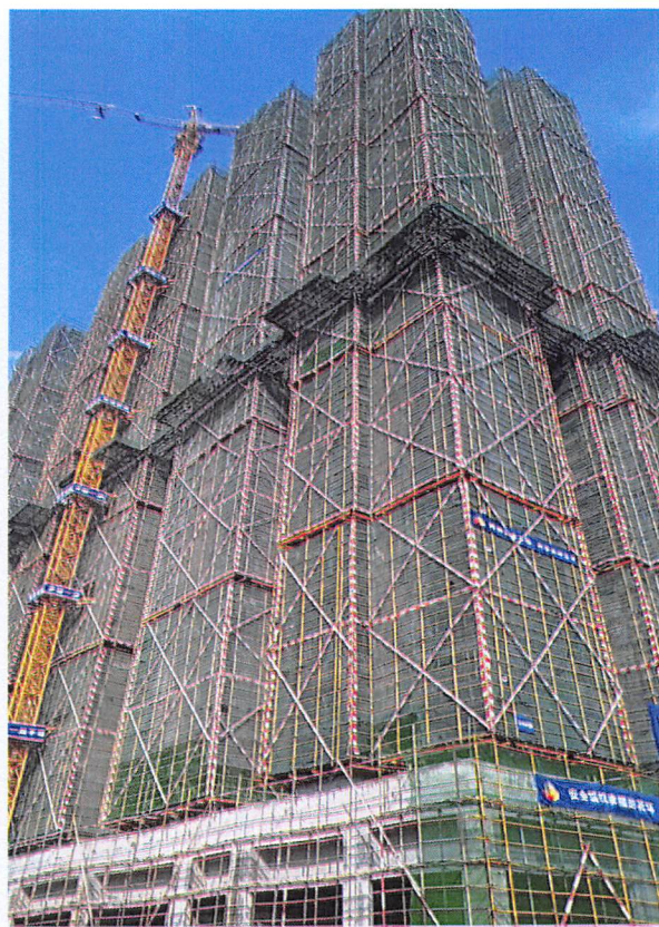
14 栋（内外墙抹灰基本完成，铝窗安装 20 层）
