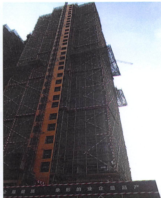
8 栋内墙抹灰基本完成，外墙抹灰差 2 层（首层除外），铝窗框安装完成 25 层）
