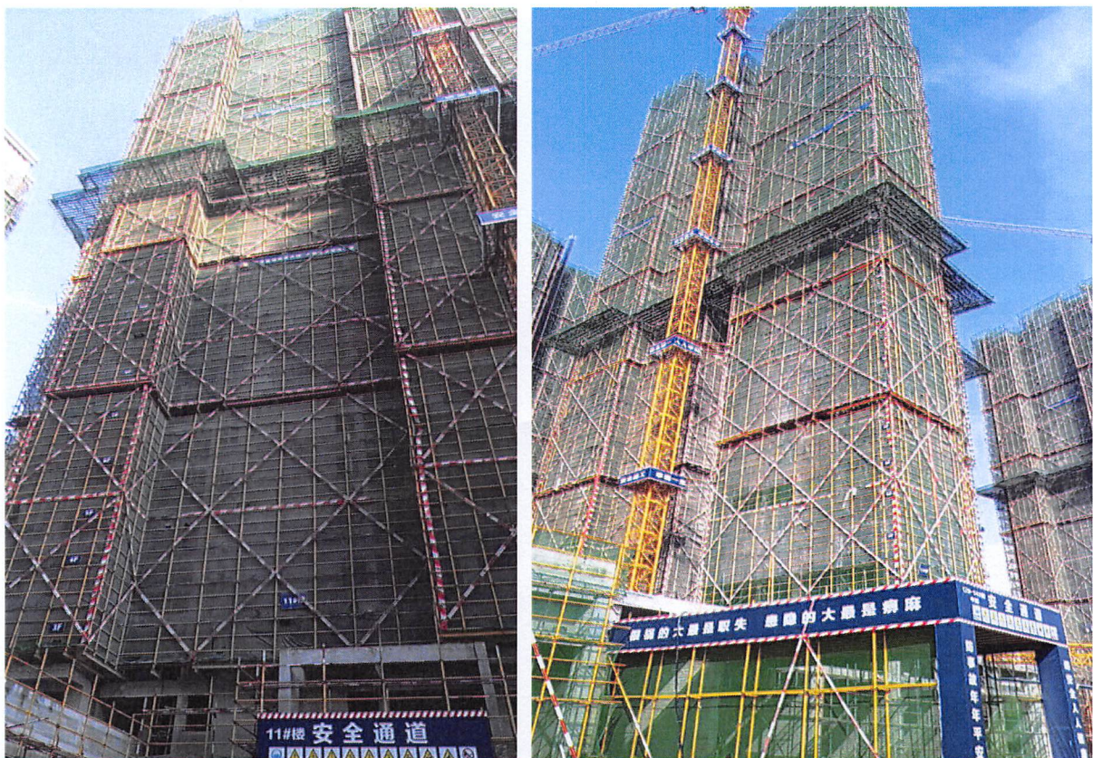
11 栋（内外墙抹灰基本完成，铝窗安装 25 层） 12 栋（内外墙抹灰基本完成，铝窗安装 15 层）
