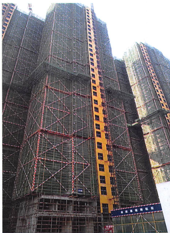
15 栋（内外墙抹灰基本完成，铝窗安装 13 层）
