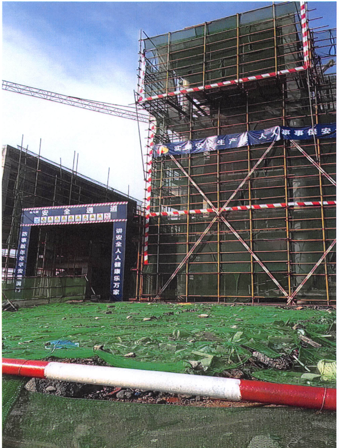
1#商铺墙体砌筑完成 30%，2#商铺材料清理中；19 区结构浇筑完成。
