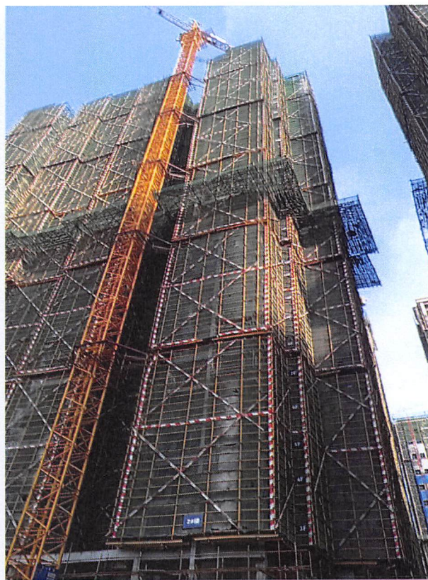
2 栋(内外墙抹灰基本完成, 铝窗安装 11 层)
