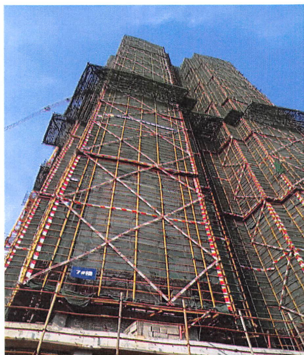
7 栋（内墙抹灰基本完成，外墙抹灰差 2 层（首层除外），铝窗框安装完成 25 层
