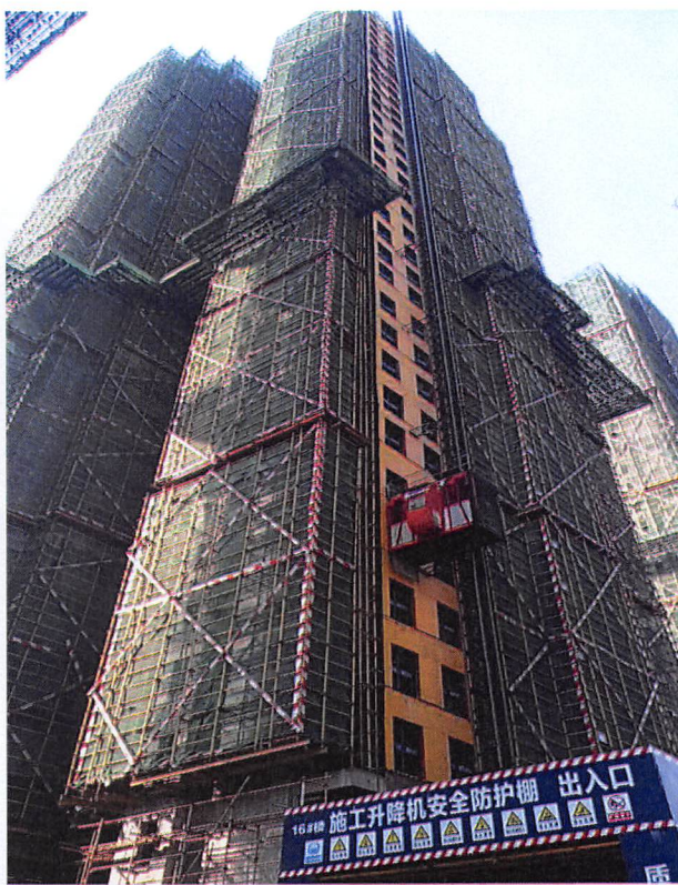
16 栋（内外墙抹灰基本完成，铝窗安装 15 层）
