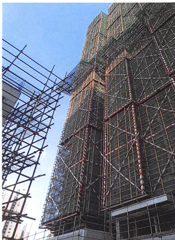
1 栋(内外墙抹灰基本完成, 铝窗安装 10 层)
