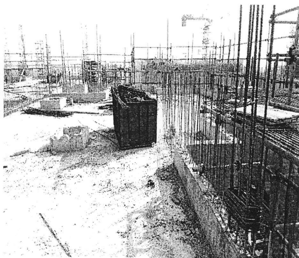
4 栋 (屋面砼浇筑完成)
