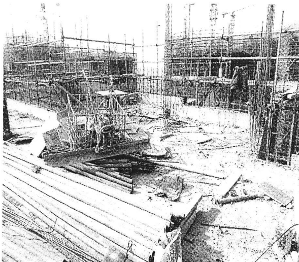
1 栋(屋面砼浇筑完成)
