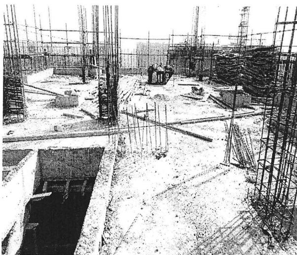
3 栋(屋面砼浇筑完成)
