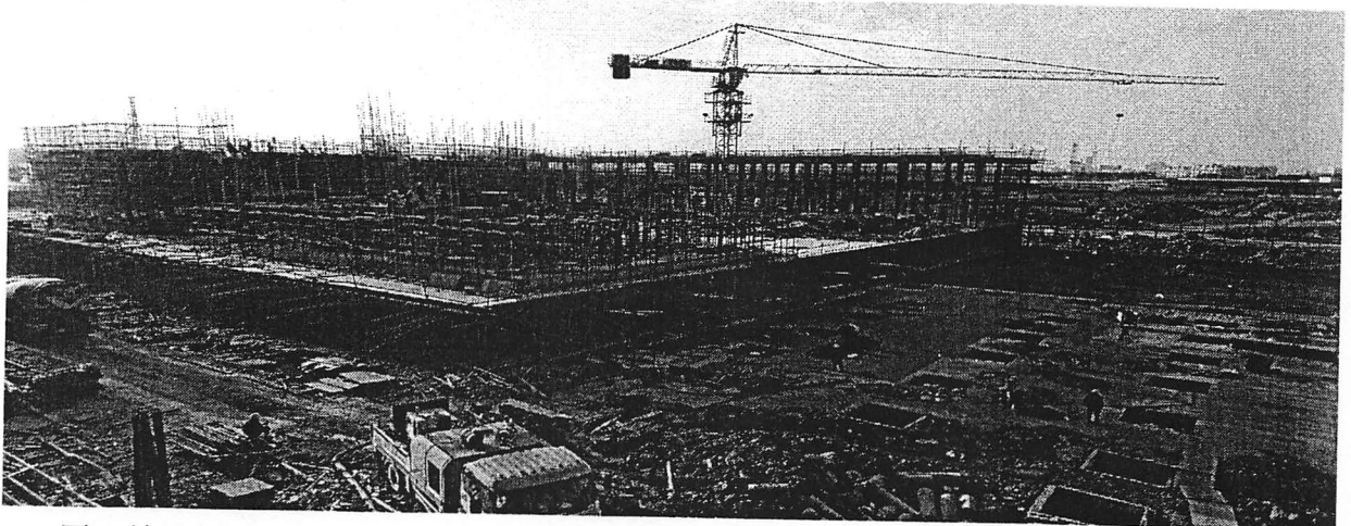
15 区（幼儿园）之①区二层商铺顶板砼完成，②区二层商铺顶板砼完成，③区二层顶板模板安装完成，④区首层楼面砼完成，⑤区底板钢筋绑扎完成 90%，⑥区承台土方开挖、砖胎模砌筑中。
