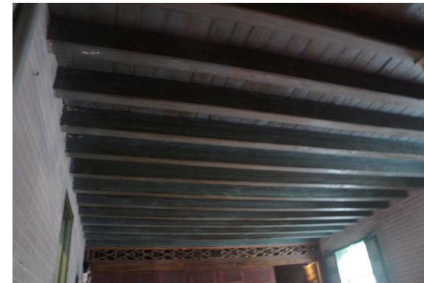
棚桁、棚板原绿色油漆褪色
