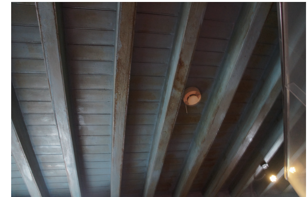
棚桁、棚板原绿色油漆褪色
