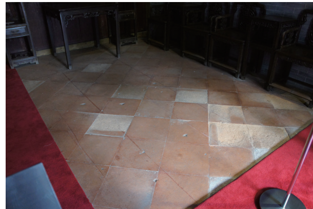
正厅大阶砖地面风化磨损
